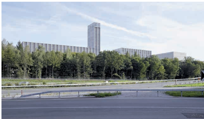
Infrastruktur Bern Forsthaus, Foto Hannes Henz
