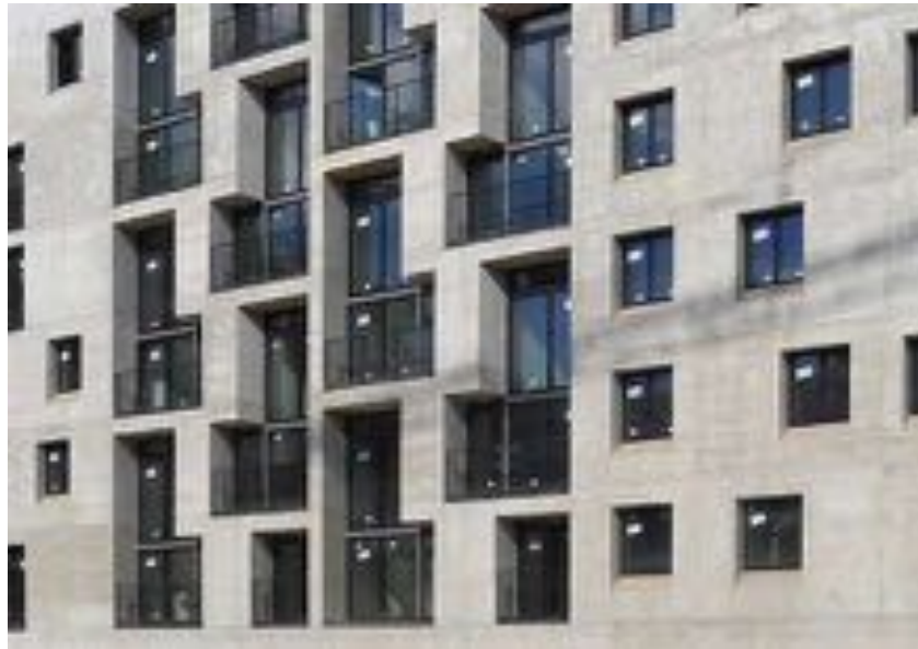
Wohnsiedlung „Mehr als Wohnen“ Zürich, (Foto: Nik Spoerri)
