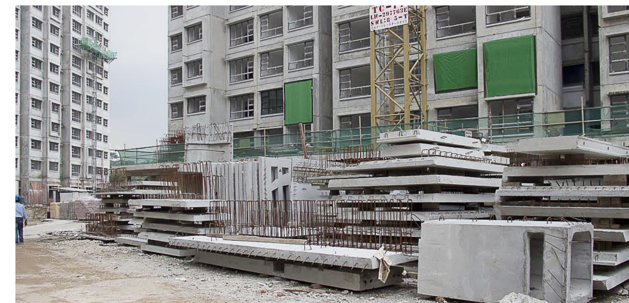
Vorfabrikation Betonfertigteile auf einer Baustelle des HDB
