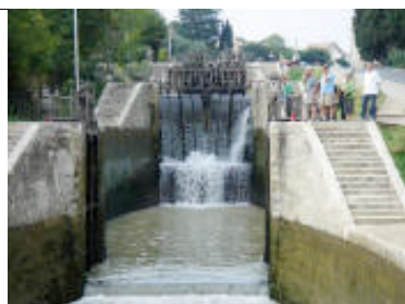
Béziers, Canal du Midi Schleusentreppe
