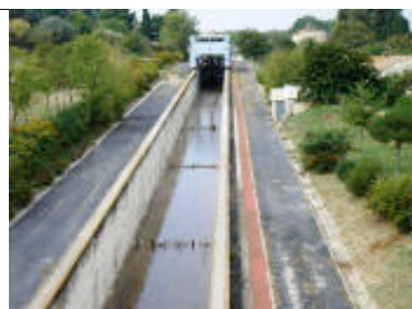
Béziers, Canal du Midi Schräglift (fahrbare Schleuse)
