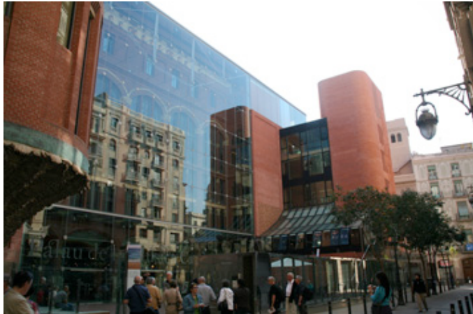
Neue Fassade am Palau de la Musica Catalana, Barcelona Oscar Tusquets
