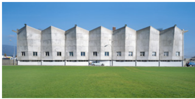
Tribüne FC Grenchen Carlo Campoleoni, 1962, Eisenbeton, Betonfaltdach. Dach und Rückwand machen die Tribüne zur Skulptur
