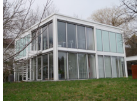
Wohnhaus Bill, Fritz Haller 1974. Stahlkonstruktion nach modularem Prinzip, ähnlich dem USM Möbelbausystem
